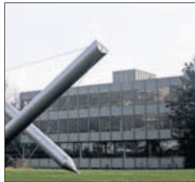
Das Bieler Gymnasium Strandboden wird renoviert.
